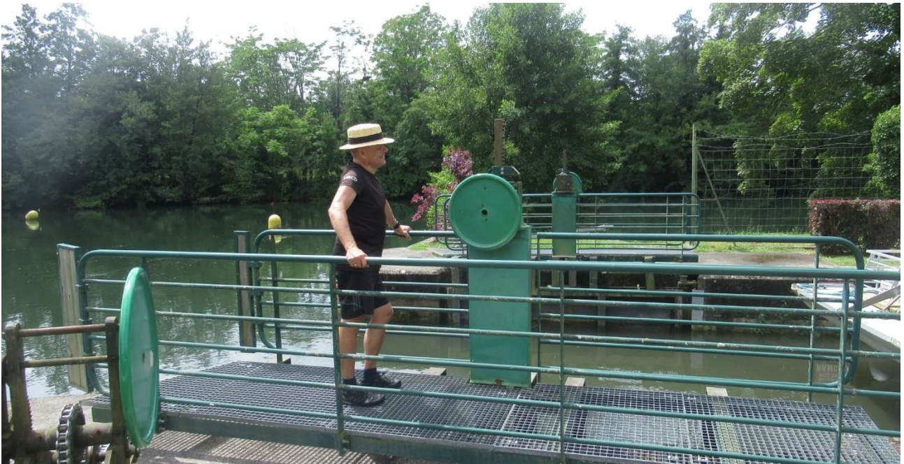
Abb. 2. Handarbeit und schwere Mechanik an den insgesamt 20 Schleusen.
